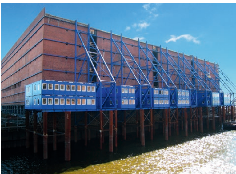
Строительный офис на площадке в особых условиях
