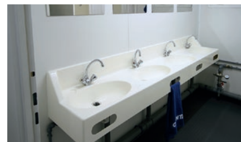
Лоток с двумя или четырьмя умывальными раковинами
