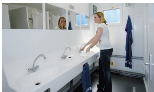
Санитарный блок-контейнер вид изнутри
