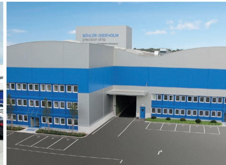
Офис на производстве
